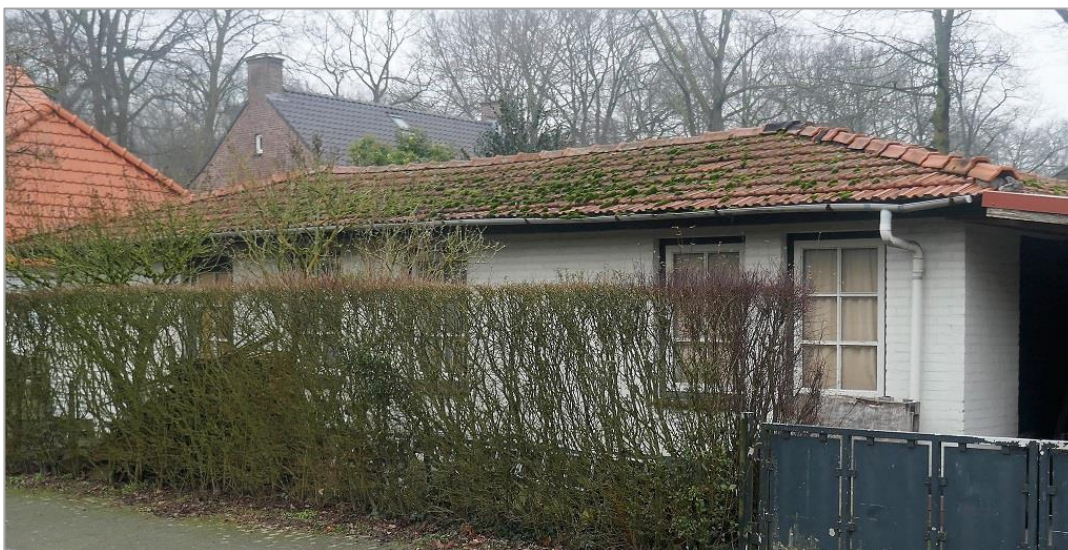
▲ Het atelier links langs de Lambertweg, achter de woning Ripsestraat 14.
